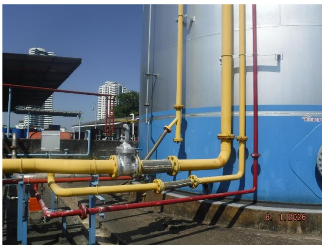
รูปที่ 2.2.1-5 Air Foam Chamber สีเหลือง, ระบบท่อดับเพลิงสีแดง
