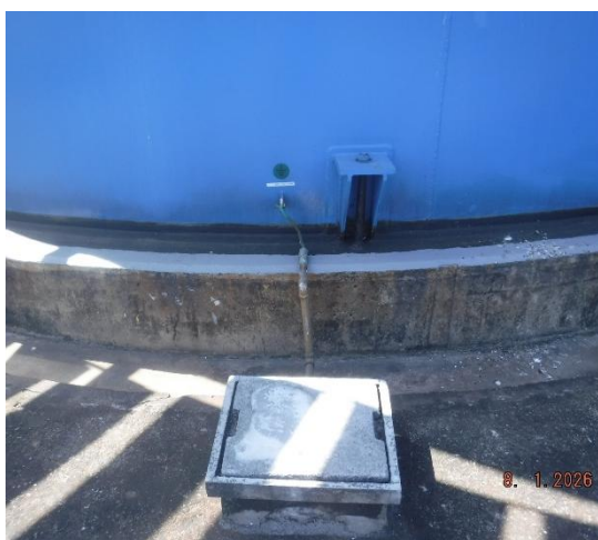
รูปที่ 2.2.1-7 สายดินของตัวถัง
