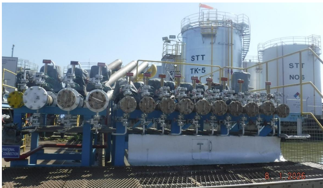
รูปที่ 1.4.5-1 ท่อขนาดเส้นผ่านศูนย์กลาง 6 นิ้ว สำหรับสูบเคมีภัณฑ์จากเรือ เพื่อส่งไปลงในถังเก็บเคมีภัณฑ์ โดยด้านล่างเป็นถังสำหรับรองรับสารเคมีที่อาจรั่วไหลจากข้อต่อของท่อถ่ายสารเคมี
