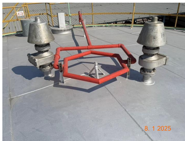
รูปที่ 2.2.1-1 Automatic Breather Valve
