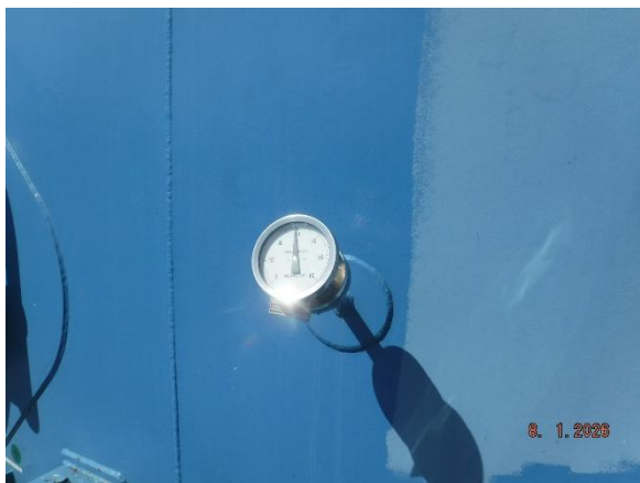
รูปที่ 2.2.1-3 เทอร์โมมิเตอร์ วัดอุณหภูมิสินค้าในแท้งค์
