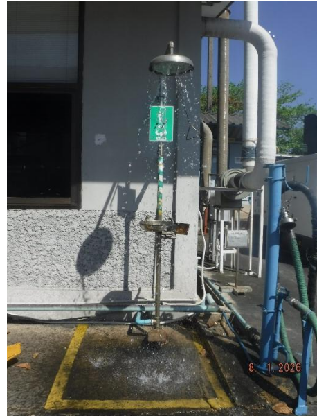
รูปที่ 2.2.4-3 ที่ล้างตาและอาบน้ำฉุกเฉิน
