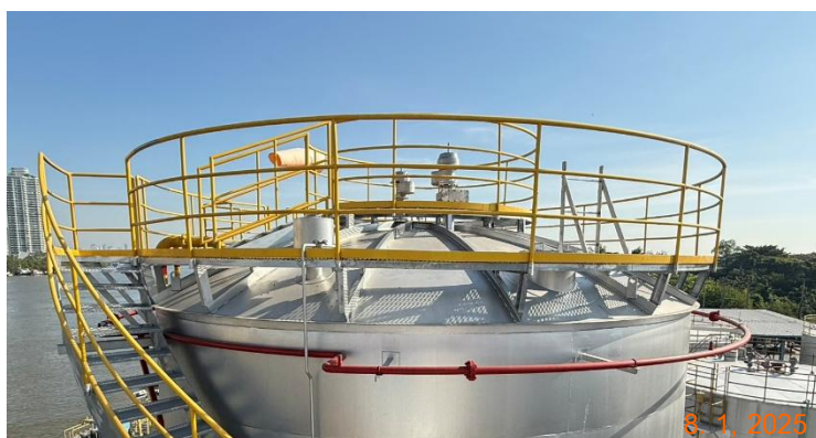
รูปที่ 2.2.1-6 ระบบท่อส่งน้ำหล่อเย็นบนดาดฟ้า
