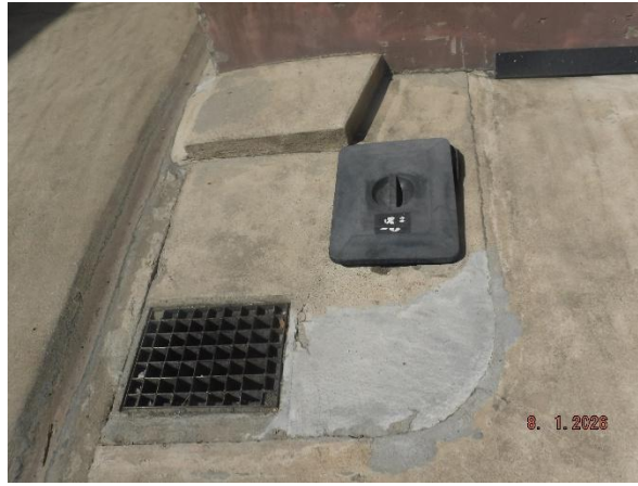
รูปที่ 1.3.4-1 จุดติดตั้งถังดักไขมันสำหรับจุดน้ำเสียจากการล้างเศษอาหาร
